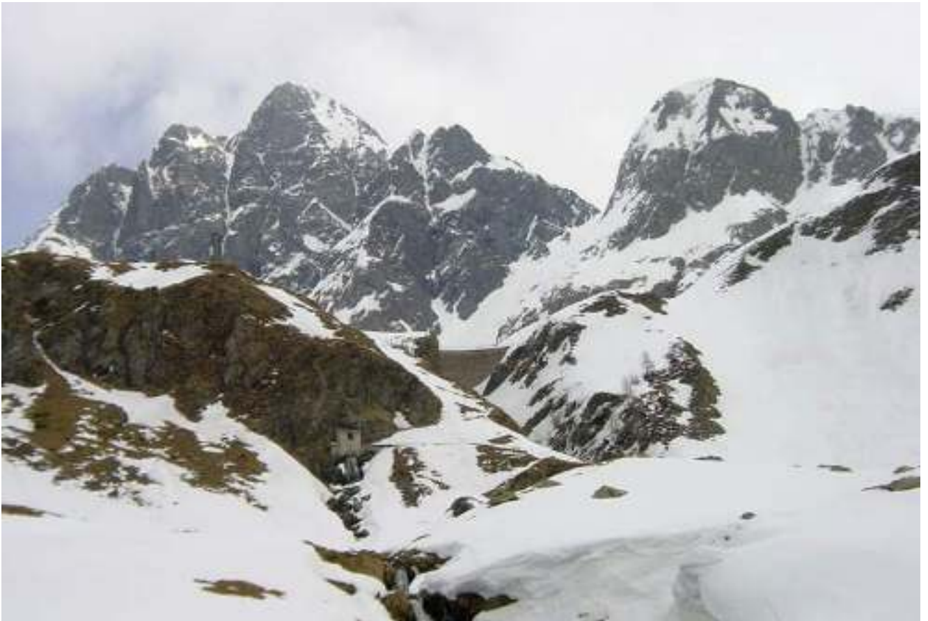
Il Monte Aga e la diga del Diavolo (foto tratta da www.valbrembanaweb.it ) in stagione invernale.
