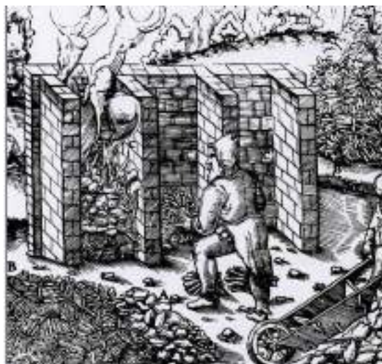
Forni di torrefazione del minerale (De Re Metallica di G. Agricola 1494-1555) (FURIA, 2000, p. 22).
