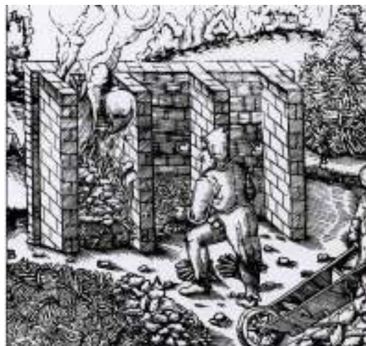
Forni di torrefazione del minerale (De Re Metallica di Giorgio Agricola 1494-1555) (FURIA, 2000, p. 22).
